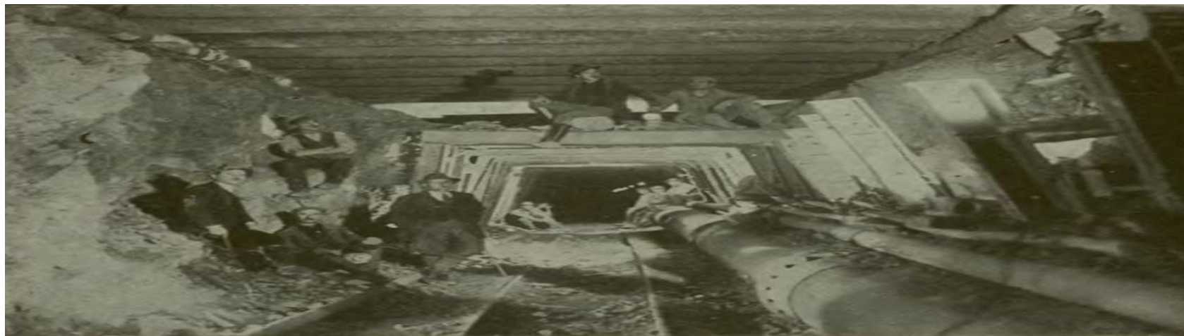
Grande Galleria dell'Appennino - Attacco verso Bologna dal pozzo n. 1 - Strozzo e avanzata inferiore.
