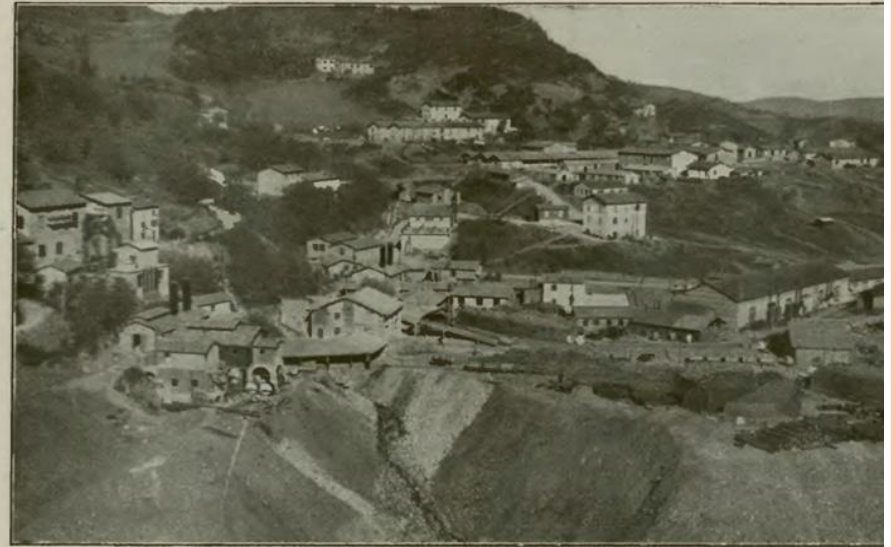
Grande Galleria dell'Appennino - Cantiere dei pozzi inclinati di Ca' di Landino.
