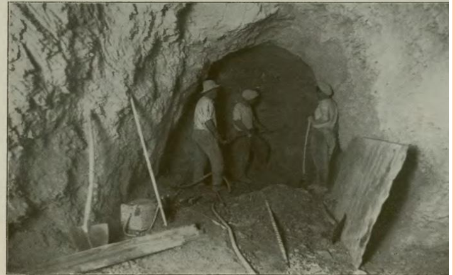
Grande Galleria dell'Appennino - Attacco all'imbocco Nord - Fronte dell'avanzata inferiore.
